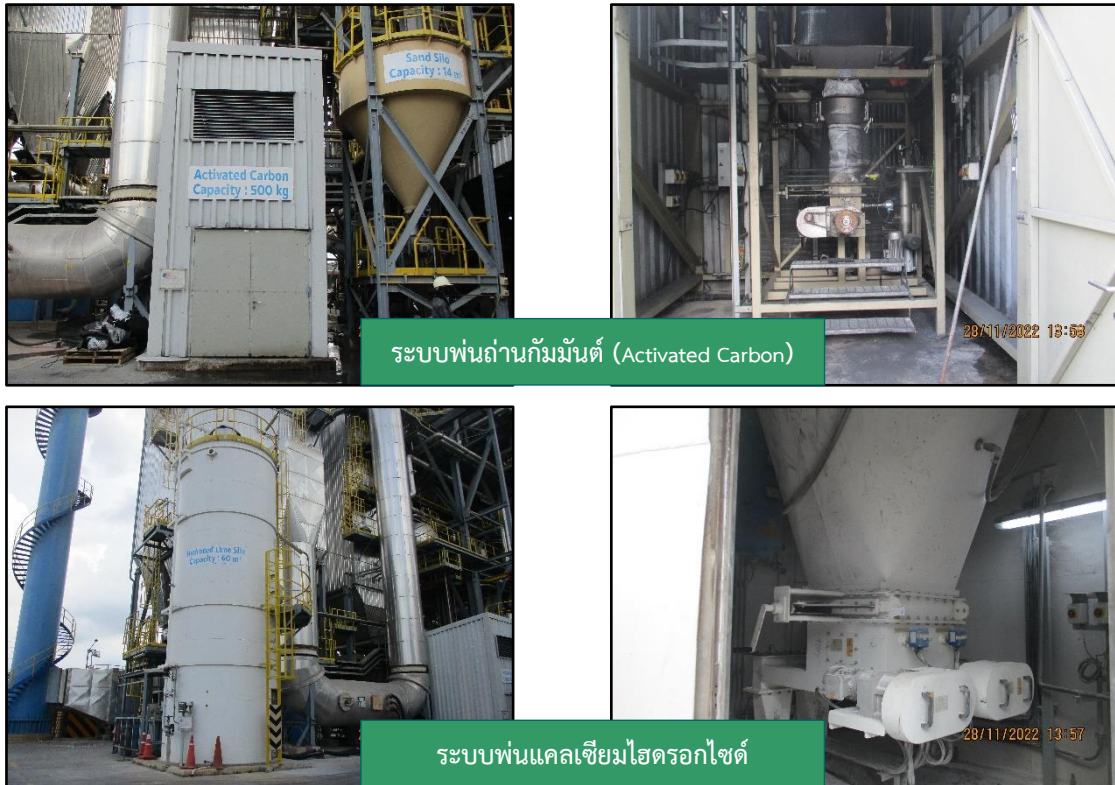
ภาพที่ 2.1 ระบบ flue gas treatment
