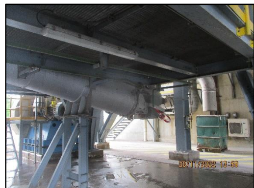
ภาพที่ 2.11 ระบบสายพานลำเลียงเก่าแบบปิดครอบ
