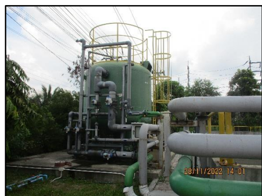
ภาพที่ 2.18 บ่อน้ำฝน (Storm Water Pond) และระบบกรองทราย
