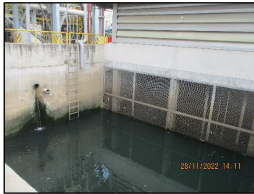
ภาพที่ 2.12 บ่อพักน้ำทิ้ง (Holding pond) ขนาด 600 ลูกบาศก์เมตร
