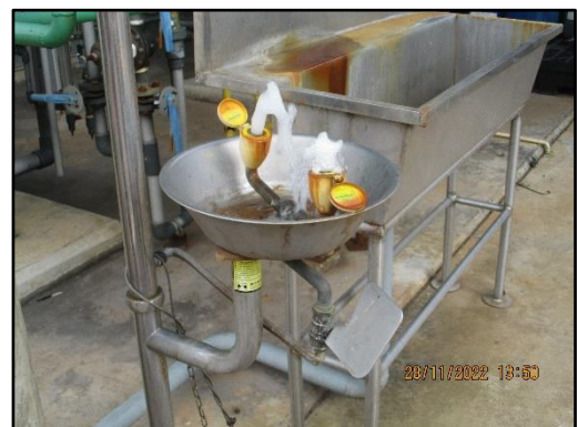
ภาพที่ 2.36 อ่างล้างตา และฝักบัวฉุกเฉิน
